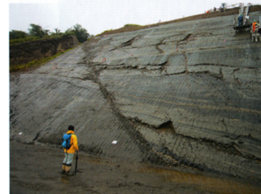
図3.21 尾根部切土斜面に現れた正断層
