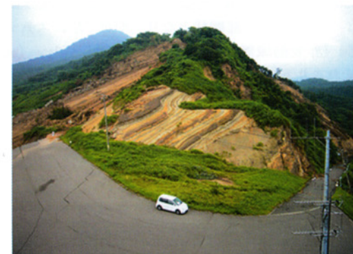
図3.20 地震発生直後の状況
